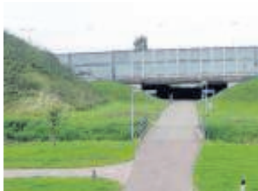
▲ Het fietstunneltje onder de A15 door. FOTO GOOGLE STREETVIEW
